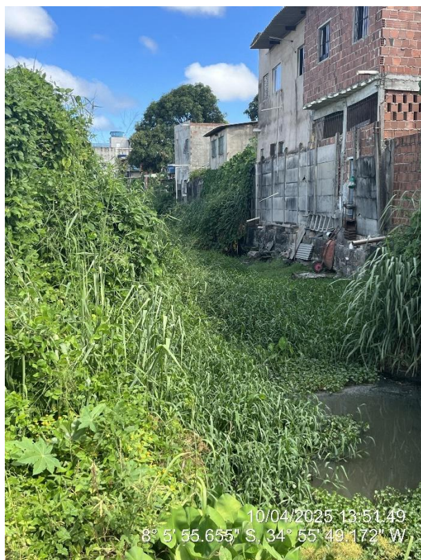
Canal Gregório de Caldas
