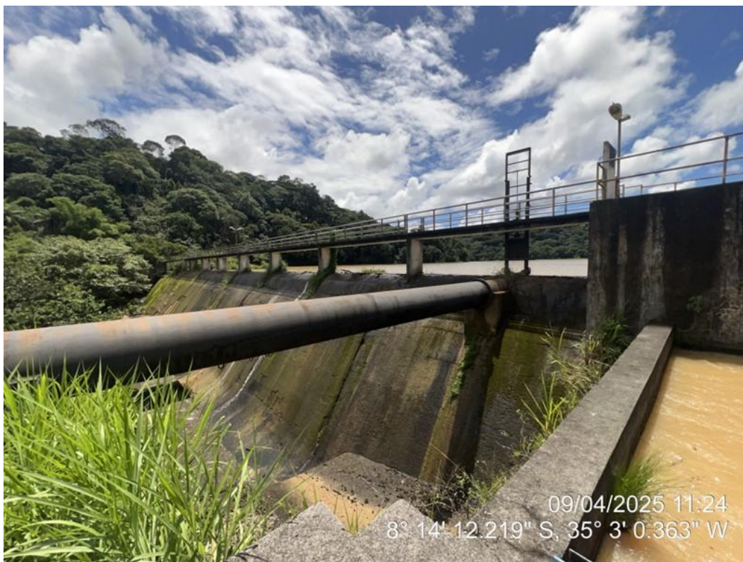
Figura 4.27 – Captação na Barragem Gurjaú
