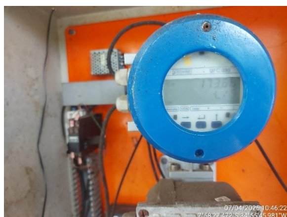
Figura 4.52 – Medidor de vazão na Estação Elevatória de Água Bruta Guabiraba I
