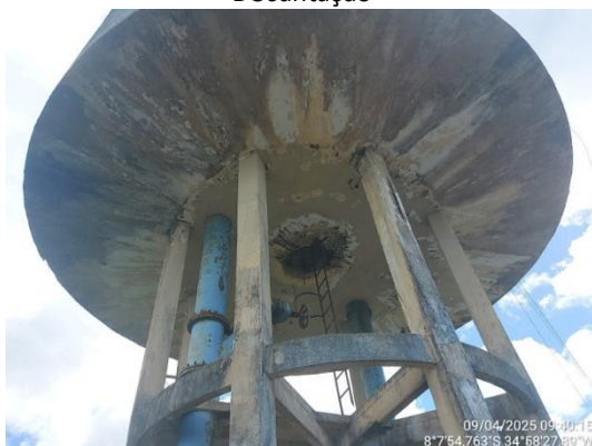
Reservatório da ETA
