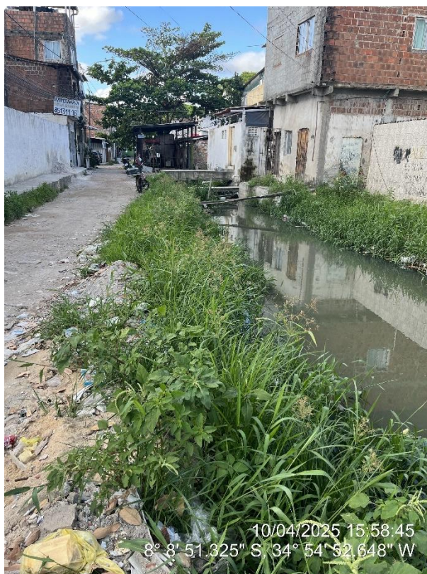
Ocupações irregulares no Canal da Vila Borborema (esquina com a Rua Florentina Ferreira)
