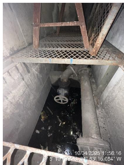
Poço de sucção
