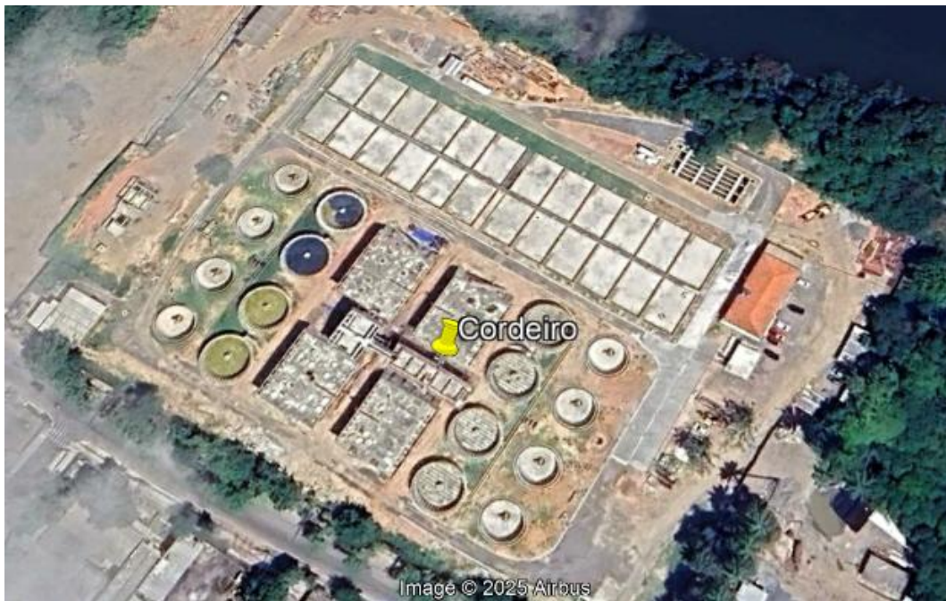
Figura 5.88 – Imagem aérea da ETE Cordeiro
