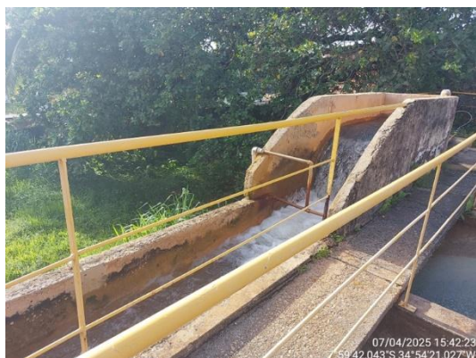
Chegada de água bruta com ressalto hidráulico e aplicação de coagulante
