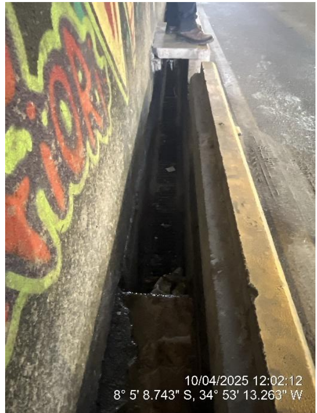
Túnel Josué de Castro
