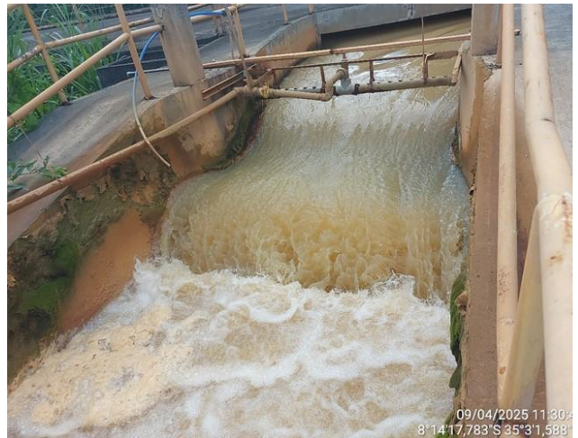
Calha Parshall com aplicação de coagulante
