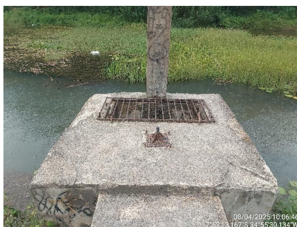
Figura 4.40 – Vista para montante da Barragem Utinga e ponto da tomada d'água com a presença de macrófitas
