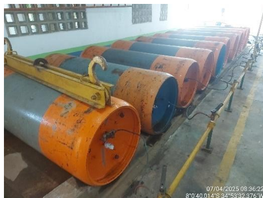
Armazenamento de cloro gás
