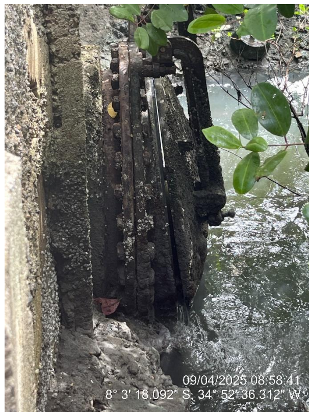
Válvula flap na desembocadura do Rio Capibaribe
