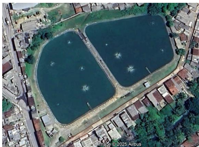
Figura 5.71 – Imagem aérea da ETE Curado
