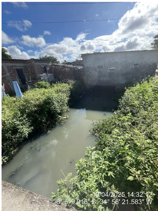
Rua Guarulhos – ocupação irregular no Canal Guarulhos
