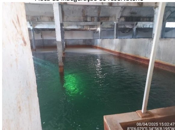
Interior do RAP Alto da Brasileira – câmara da esquerda
