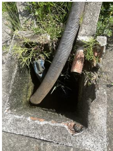
Ponto de lançamento do recalque
