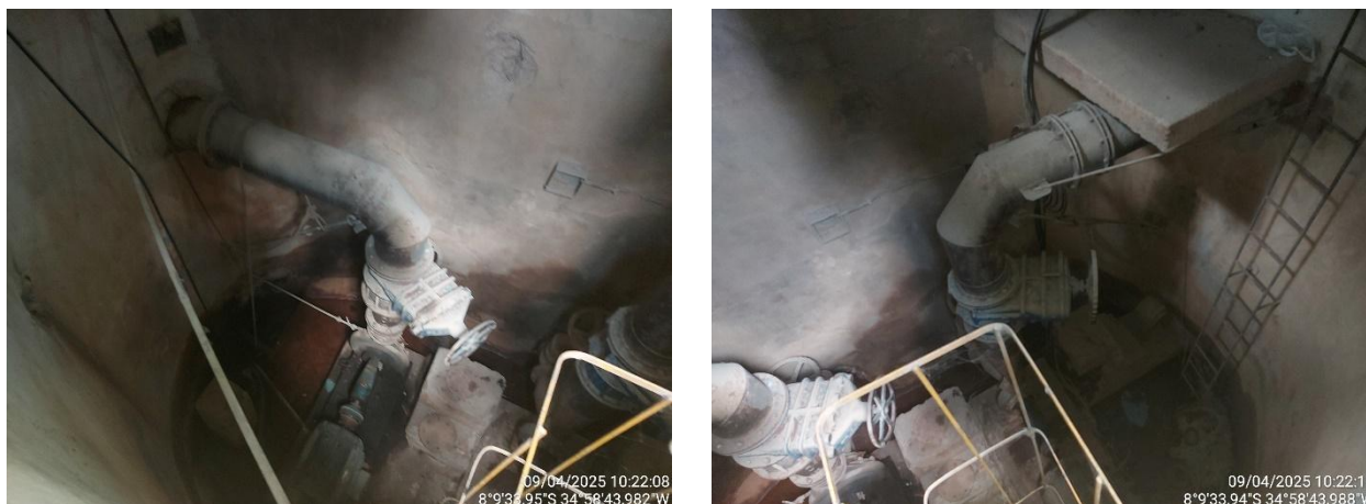
Figura 4.58 – Estação Elevatória de Água Bruta Marcos Freire
