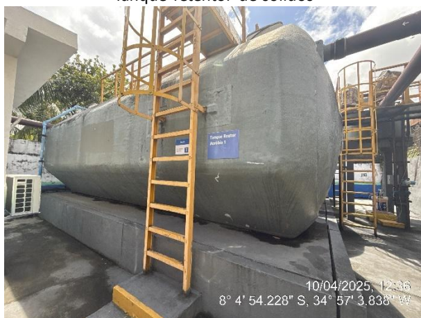
Tanque aeróbio
