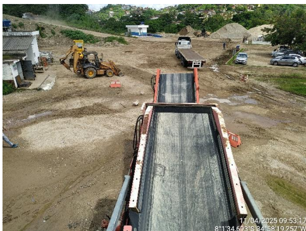
Esteira do triturador de RCC
