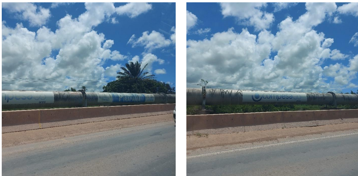
Figura 4.79 – Adutora de 1880 mm do sistema Pirapama na BR-101.
