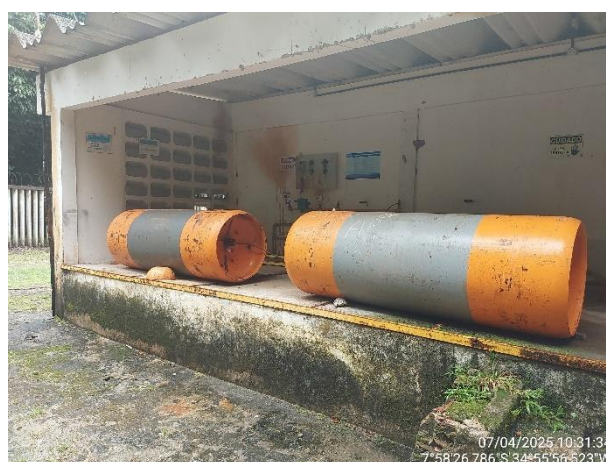
Figura 4.67 – Poço de sucção e armazenamento de cloro gás na EEAT Guabiraba II
