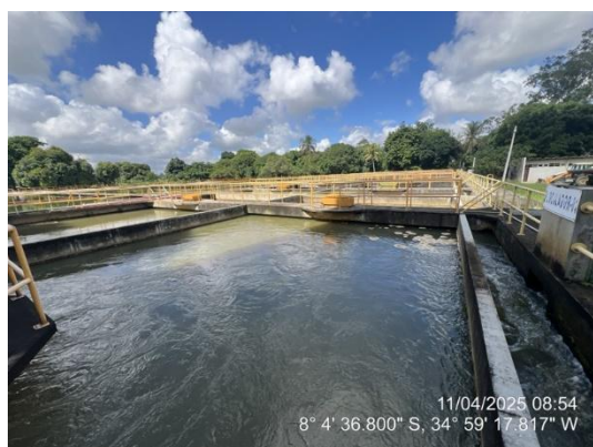
Floculação mecanizada
