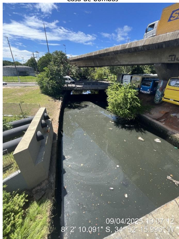
Lançamento do recalque
