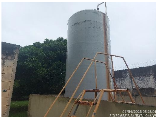
Armazenamento de sulfato de alumínio
