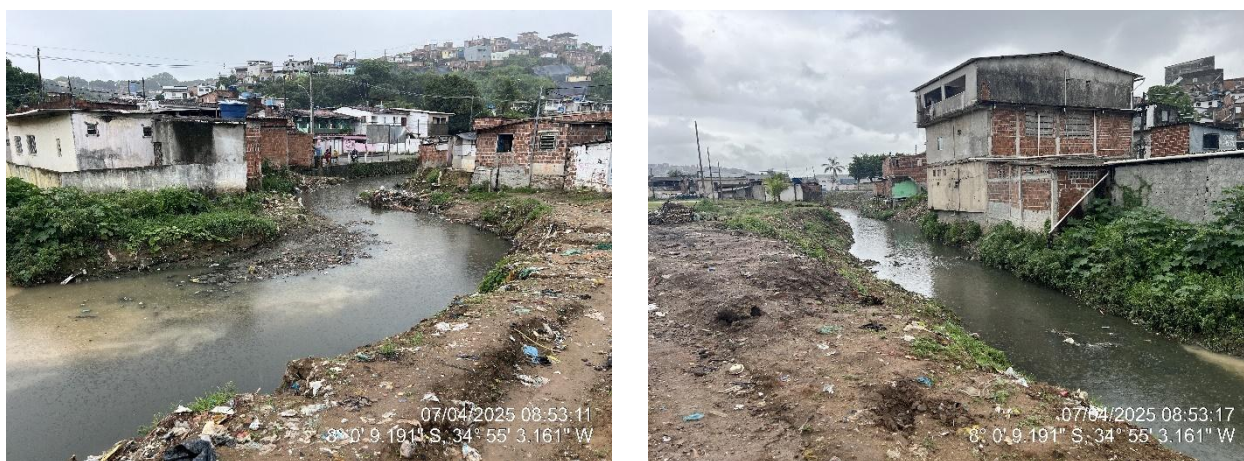
Figura 7.32 – Limpeza do rio Morno
