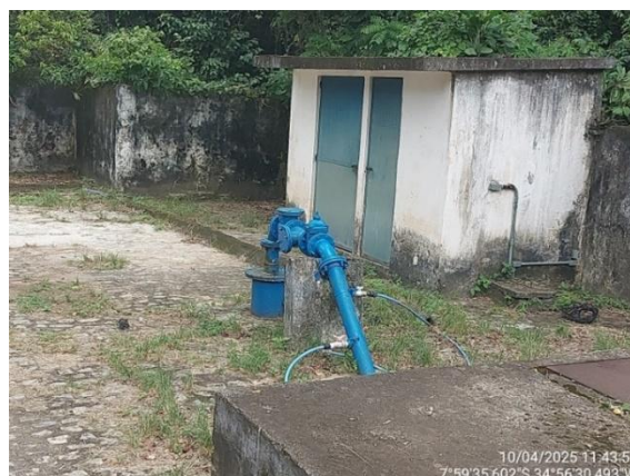
Figura 4.73 – Poço Valparaíso com aplicação de cloro no barrilete
