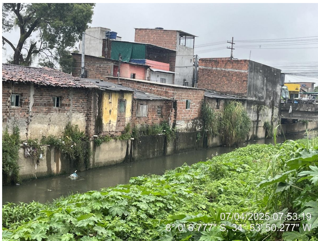
Lançamento de esgoto
