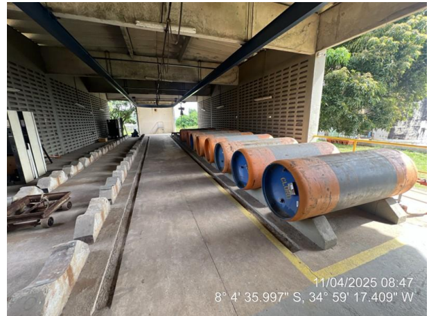
Armazenamento de cloro
