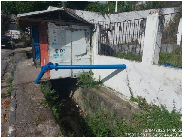
Poço Córrego da Bica, com esgoto a céu aberto em frente
