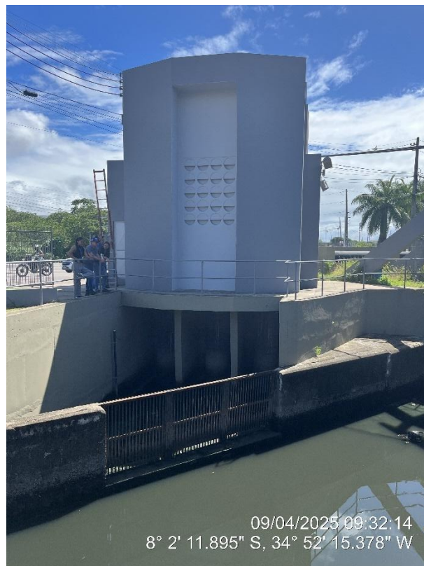
Casa de bombas
