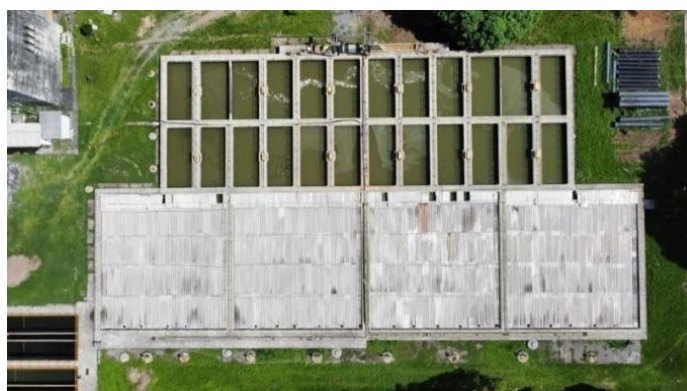
Floculação mecanizada e decantação
