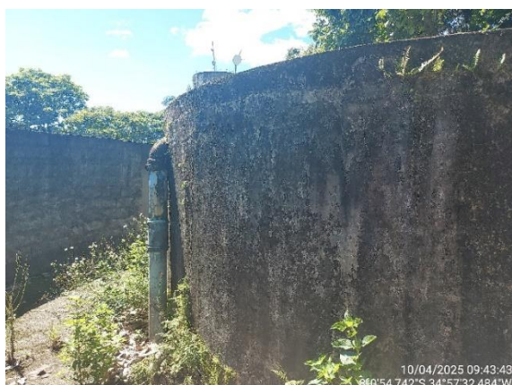
Chegada da água tratada
