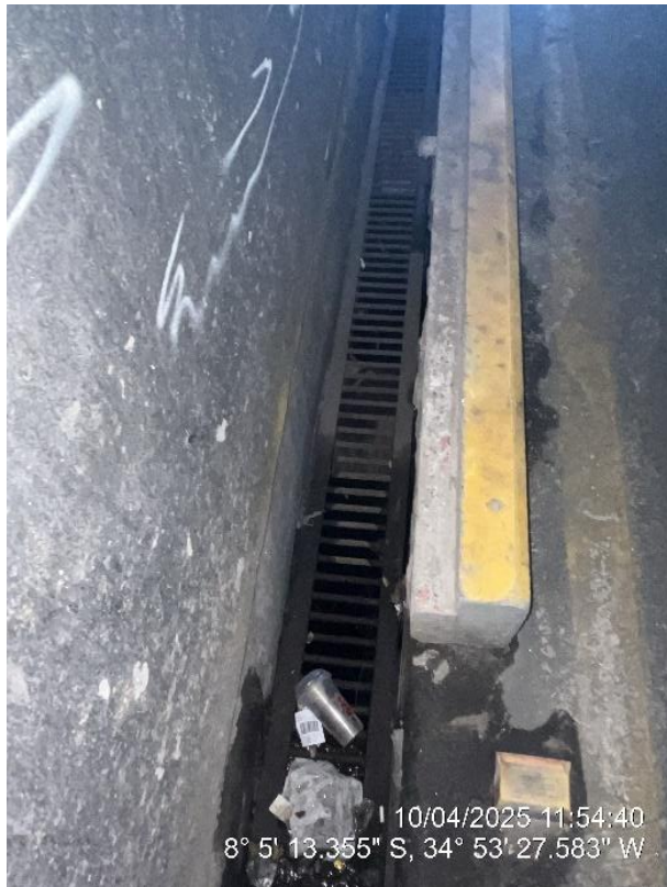
Túnel Josué de Castro
