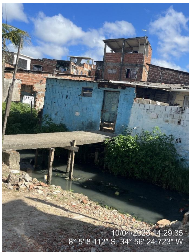
Rua Guarulhos – ocupação irregular no Canal Guarulhos
