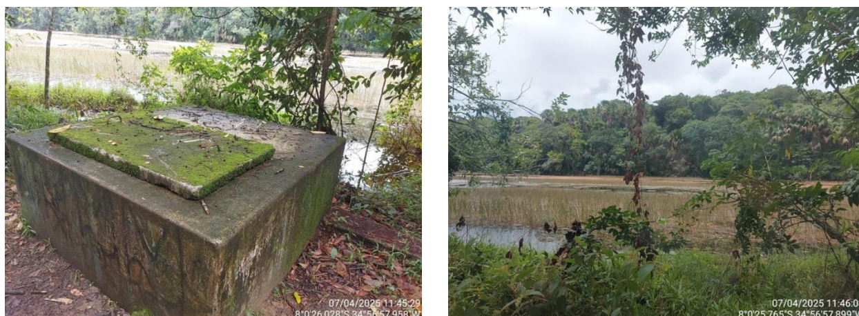
Figura 4.64 – Captação com poço amazonas no Açude do Meio
