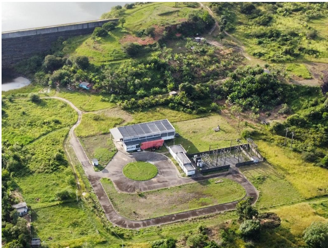
Figura 4.6 – Estação Elevatória de Água Bruta Pirapama
