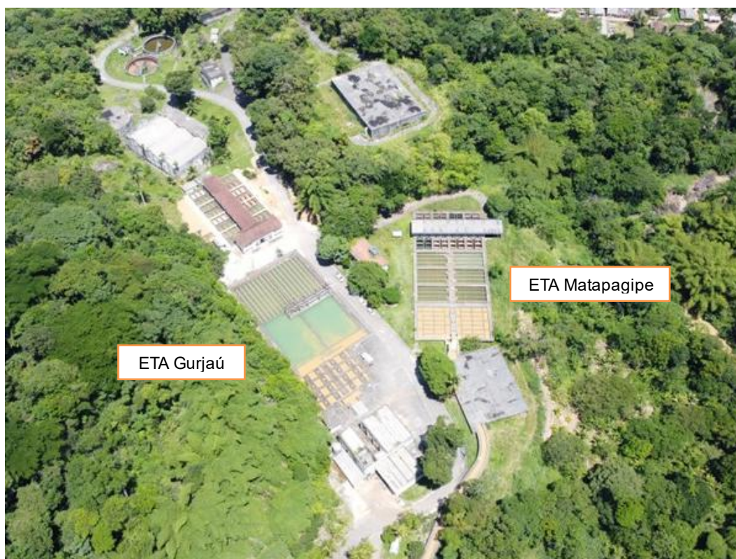
Figura 4.28 – Estações de tratamento de água Gurjaú e Matapagipe
