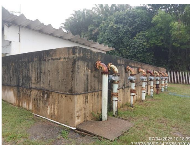
Figura 4.67 – Poço de sucção e armazenamento de cloro gás na EEAT Guabiraba II
