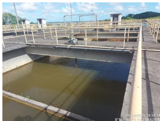
Floculação mecanizada
