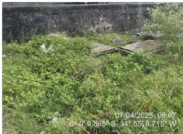
Fossa inativa Conjunto Hab. Dom Helder Câmara
