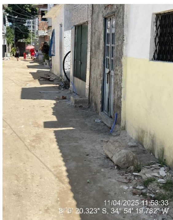
Figura 4.95 – Obra de urbanização integrada na comunidade do Bem com a finalização da etapa de ligações prediais de água
