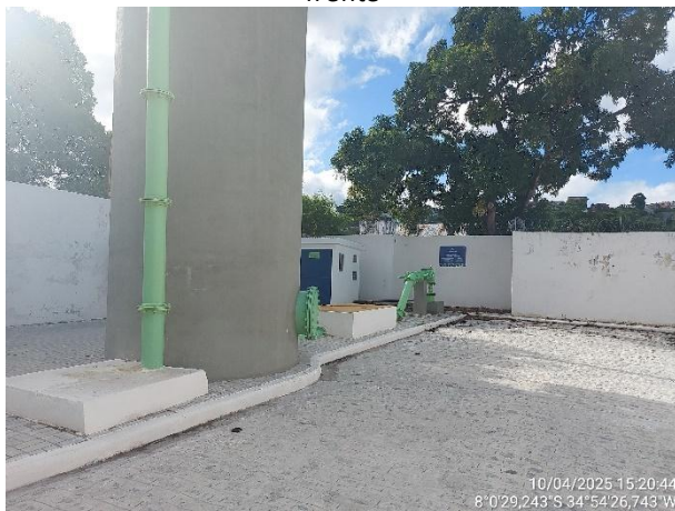
Poço Córrego do Tiro IV, recém reformado
