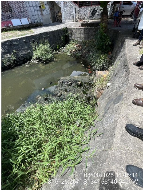
Ponto de lançamento do bombeamento
