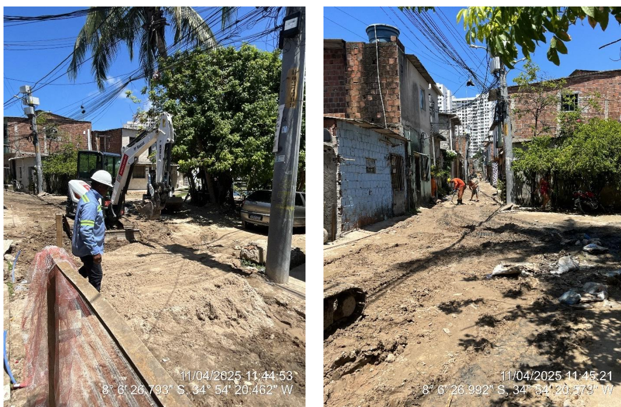
Figura 7.29 – Obras em execução – Comunidade do Bem
