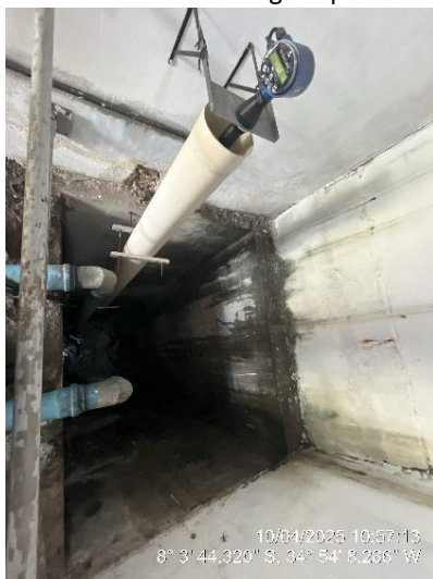
Poço de sucção
