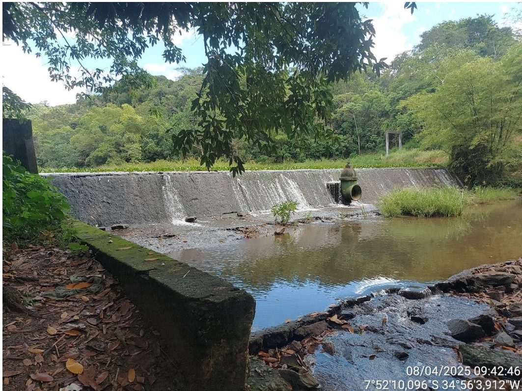
Figura 4.37 – Vista frontal da Barragem Pitanga
