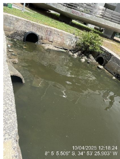
Ponto de lançamento final do recalque
