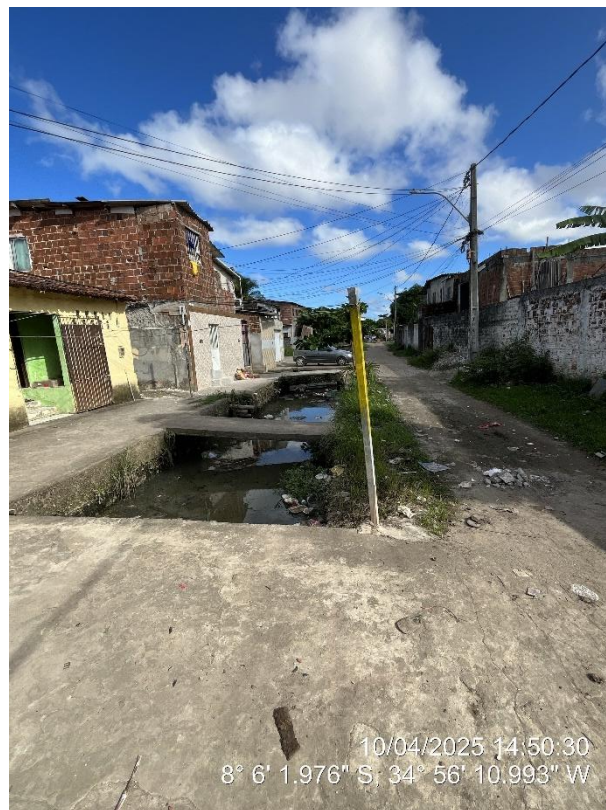
Rua das Laranjeiras – ocupações irregulares
