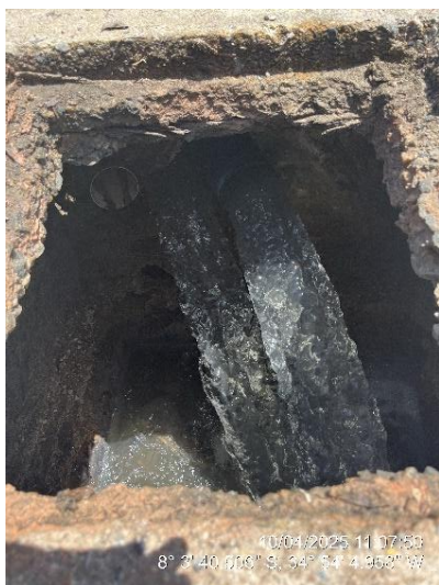
Ponto de lançamento do recalque
