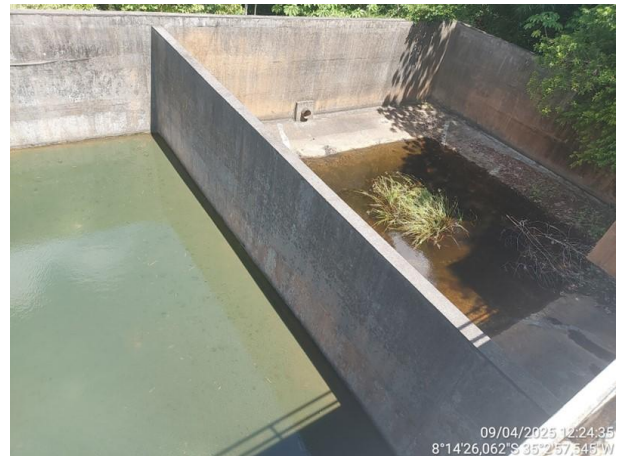
Figura 4.29 – Estação de tratamento de efluentes desativada das ETA Gurjaú e Matapagipe
