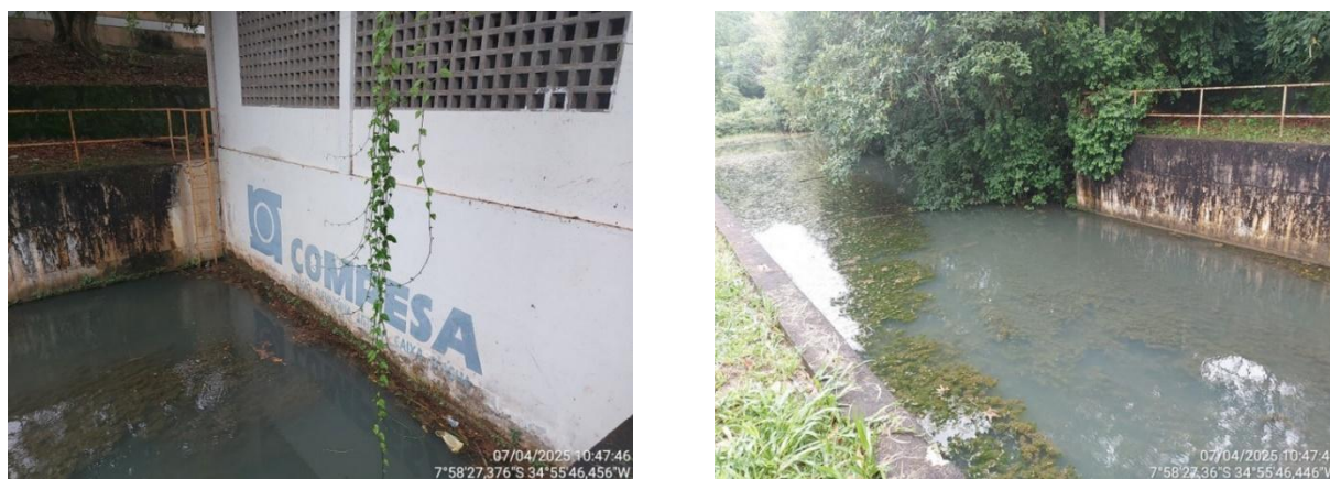
Figura 4.48 – Captação no Rio Beberibe
