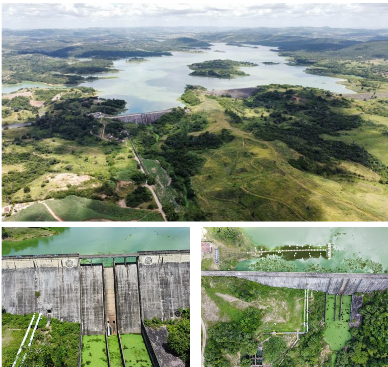
Figura 4.13 – Captação na Barragem Tapacurá
