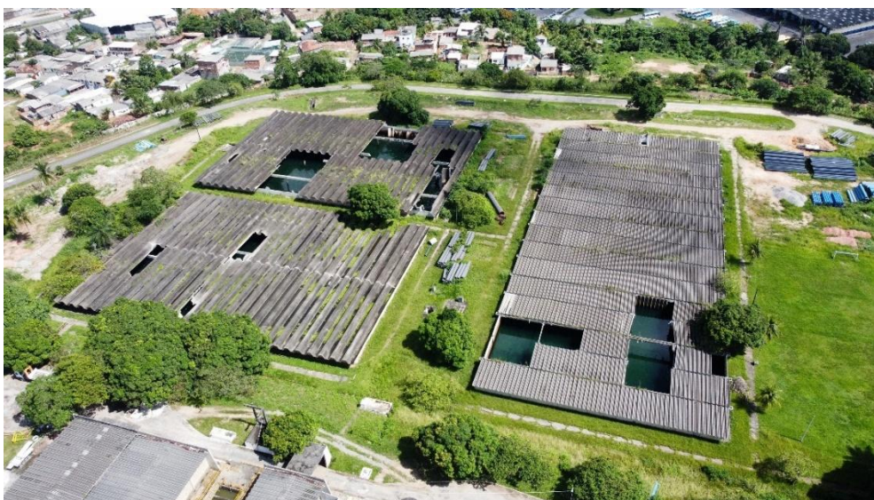
Figura 4.23 – Reservatórios de partida do Sistema Integrado Tapacurá
