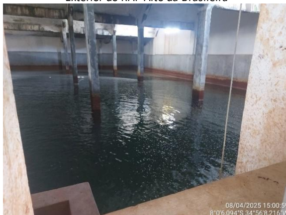
Interior do RAP Alto da Brasileira – câmara da direita
