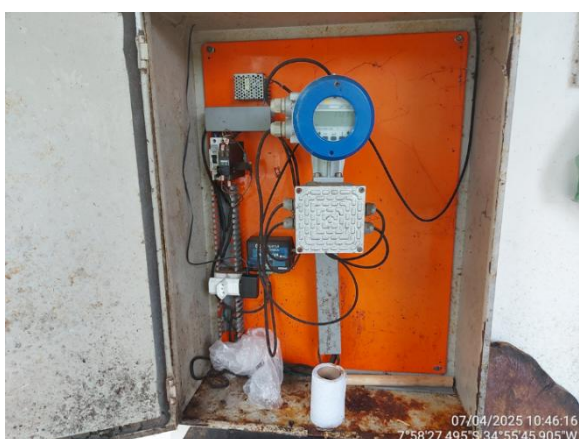
Figura 4.52 – Medidor de vazão na Estação Elevatória de Água Bruta Guabiraba I
