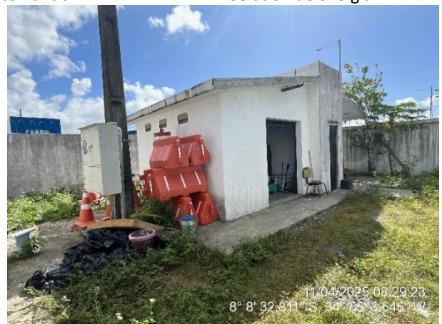
Casa de máquinas
