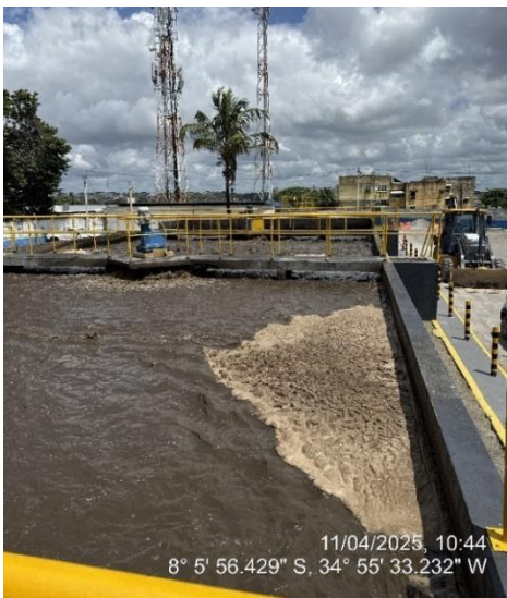
Tanque de aeração
