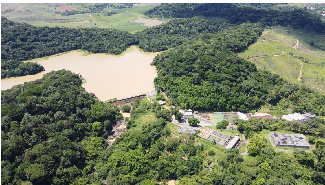
Figura 4.25 – Barragem e estações de tratamento do sistema integrado Gurjaú
