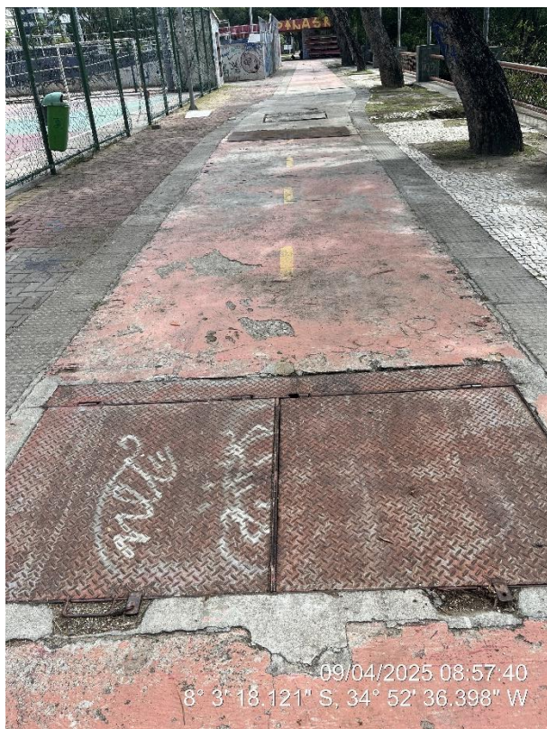
Reservatório sob a calçada
