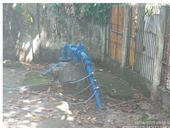
Figura 4.75 – Poço Sítio dos Pintos com aplicação de cloro no barrilete
