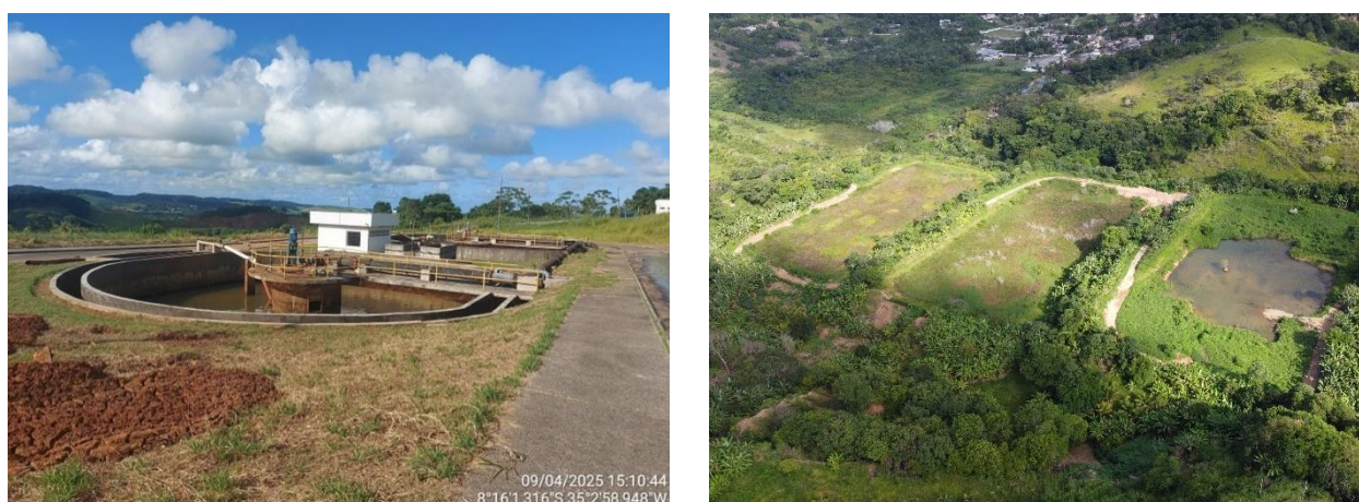
Figura 4.8 – Unidade de tratamento de lodo da ETA Pirapama
