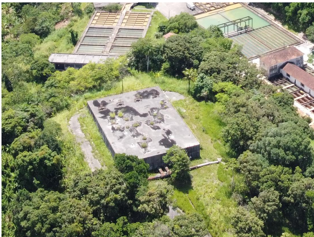
Figura 4.34 – Reservatório de partida do Sistema Integrado Gurjaú
