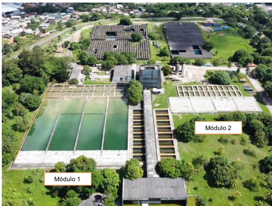
Figura 4.18 – ETA Castelo Branco
