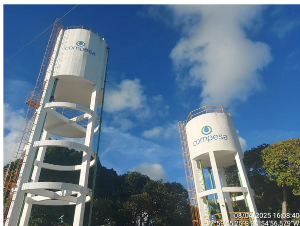
REL Alto da Esperança em operação (esquerda, 200 m 3 ) e não inaugurado (direita, 50 m 3 )
