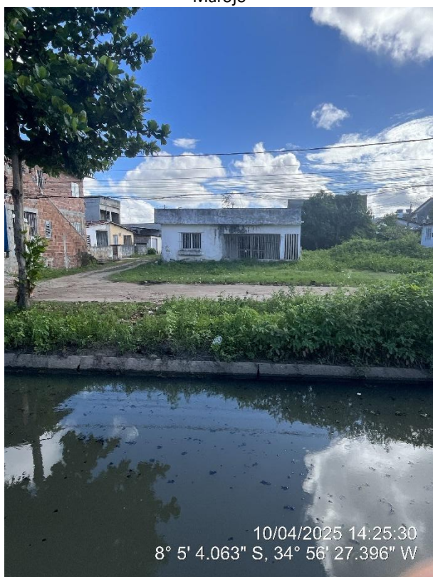
Rua Guarulhos – residência que sofreu recalque da fundação
