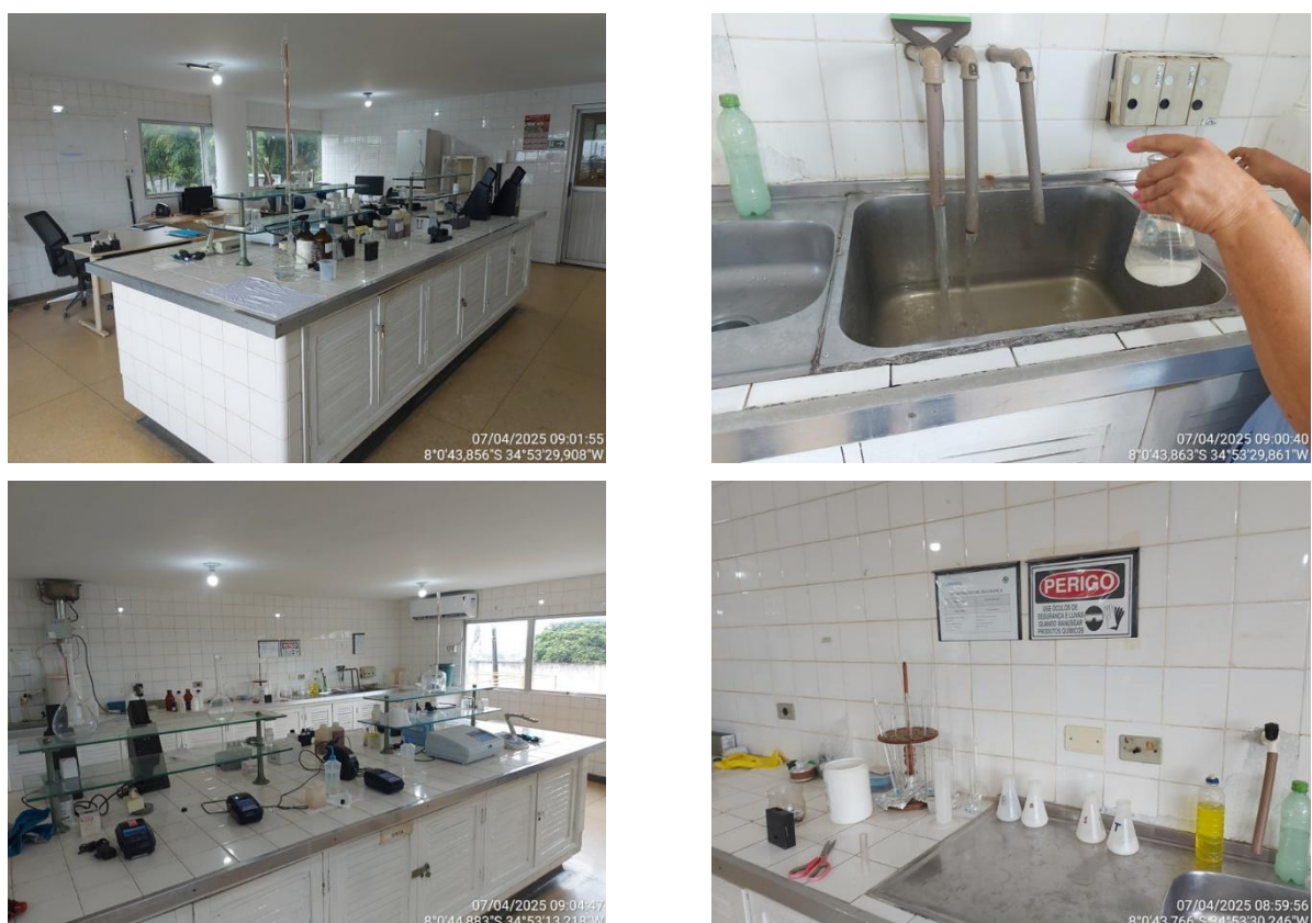
Figura 4.44 – Laboratório de análise de qualidade de água da ETA Alto do Céu
