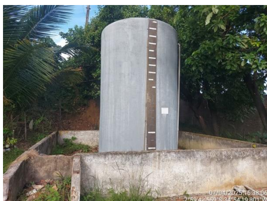
Armazenamento de sulfato de alumínio
