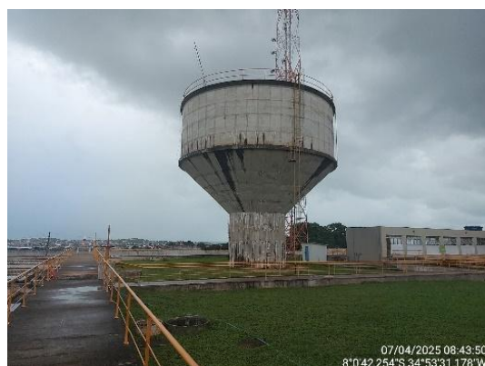
Reservatório da ETA
