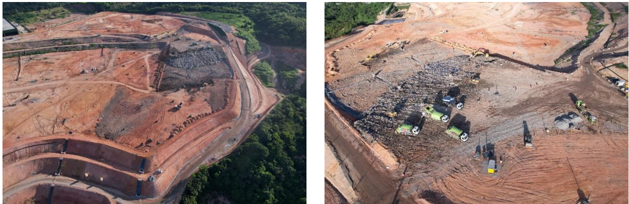
Figura 6.38 – Valas de aterramento no Ecoparque Jaboatão
