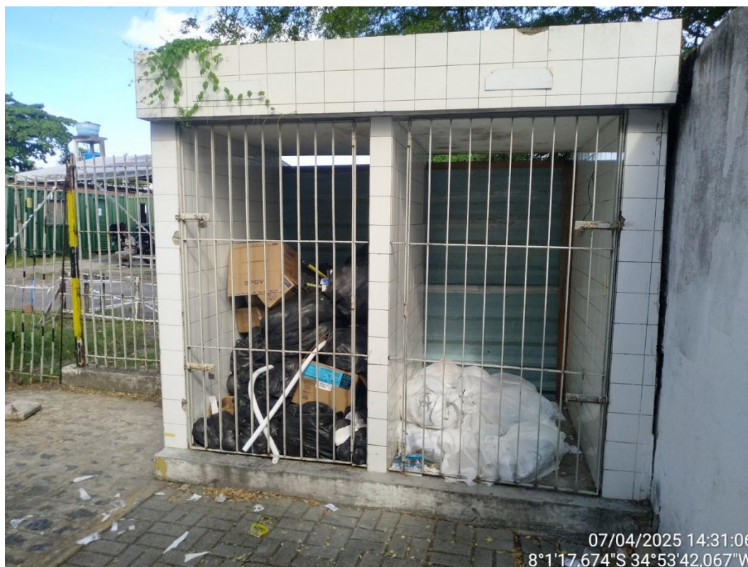
Figura 6.62 – Armazenamento externo de RSS na Policlínica (Grupos A, B, C, D e E)
