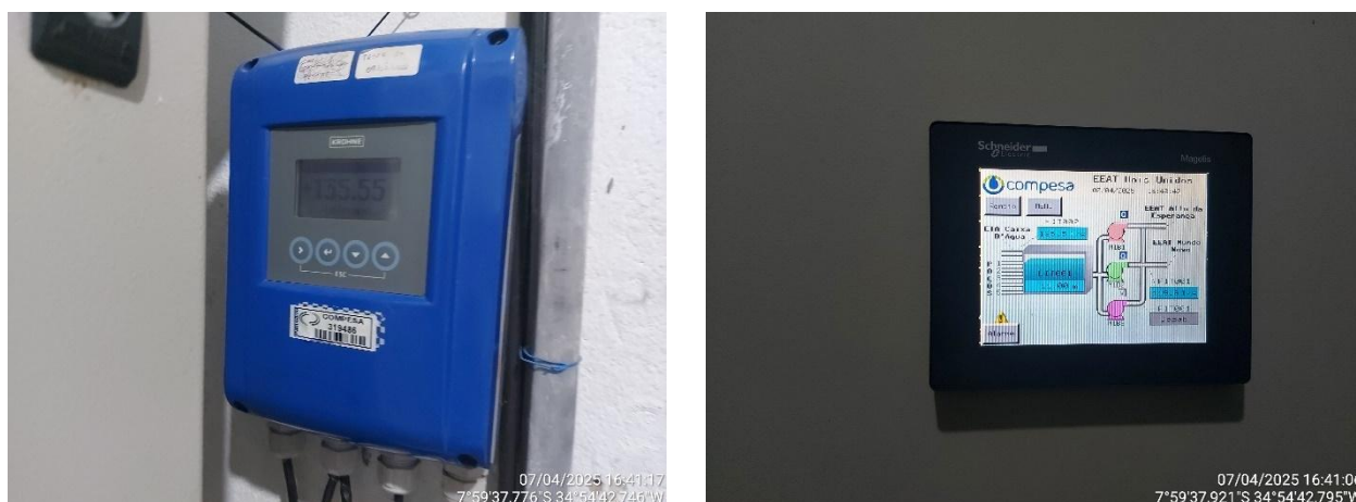
Figura 4.83 – Exemplo de sistema de medição de vazão e datalogger em EEAT
