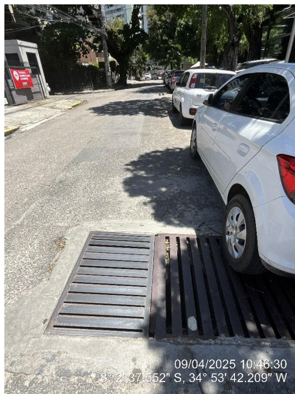
Final do reservatório entre as ruas Dr. Miguel de Lima e Dr. Vicente Meira
