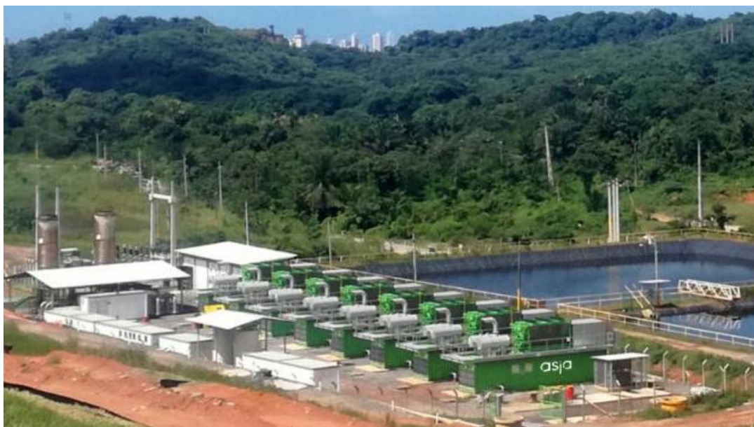
Figura 6.40 – Planta de geração de energia do Ecoparque Jaboatão
